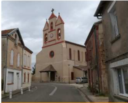
Réfection église de Lunel en partenariat avec l'association
