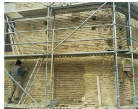
Travaux sur l'église de Rouzet en partenariat avec l'association
