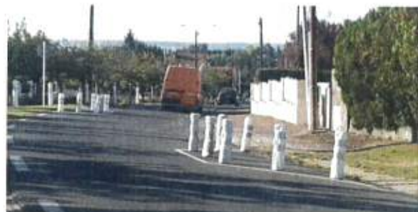
Exemple d'aménagements - Photo non contractuelle
