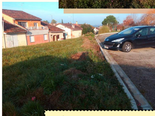
Début de terrassement des espaces verts place du Sol
