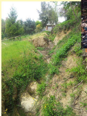
Stabilisation du fossé du Cantarel par enrochement
