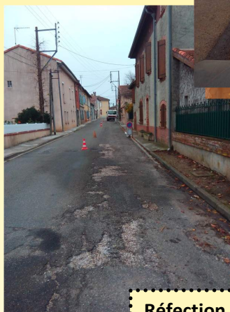
Réfection de la rue de l'Égalité
