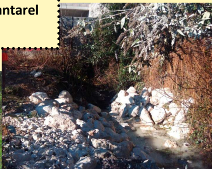
Stabilisation du talus et du fossé rue du Levant par enrochement
