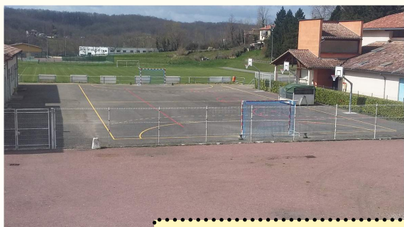
Remise en état de l'aire de jeux extérieure à côté du gymnase
