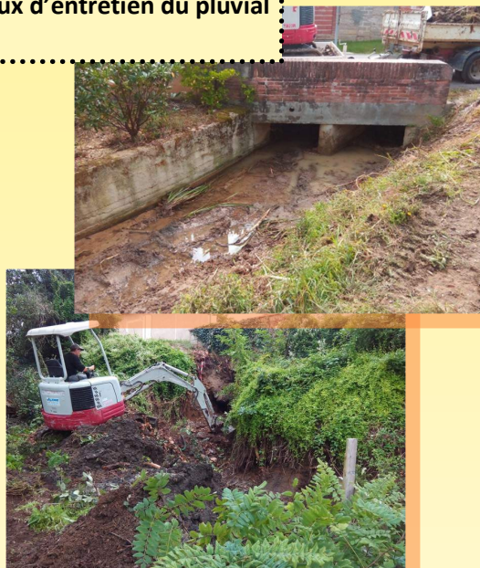
Travaux d'entretien du pluvial
