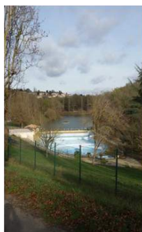
Peinture des murs de la piscine par les élus, création d'un accès pour personnes à mobilité réduite.
