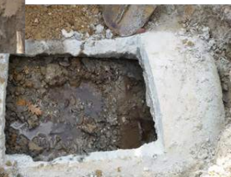
Travaux de réfection et nettoyage d'un busage obstrué par des racines.
